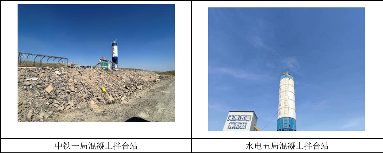
图 2.2-2 主要临建工程现状图片
