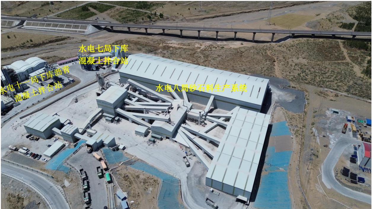
下水库临建设施
