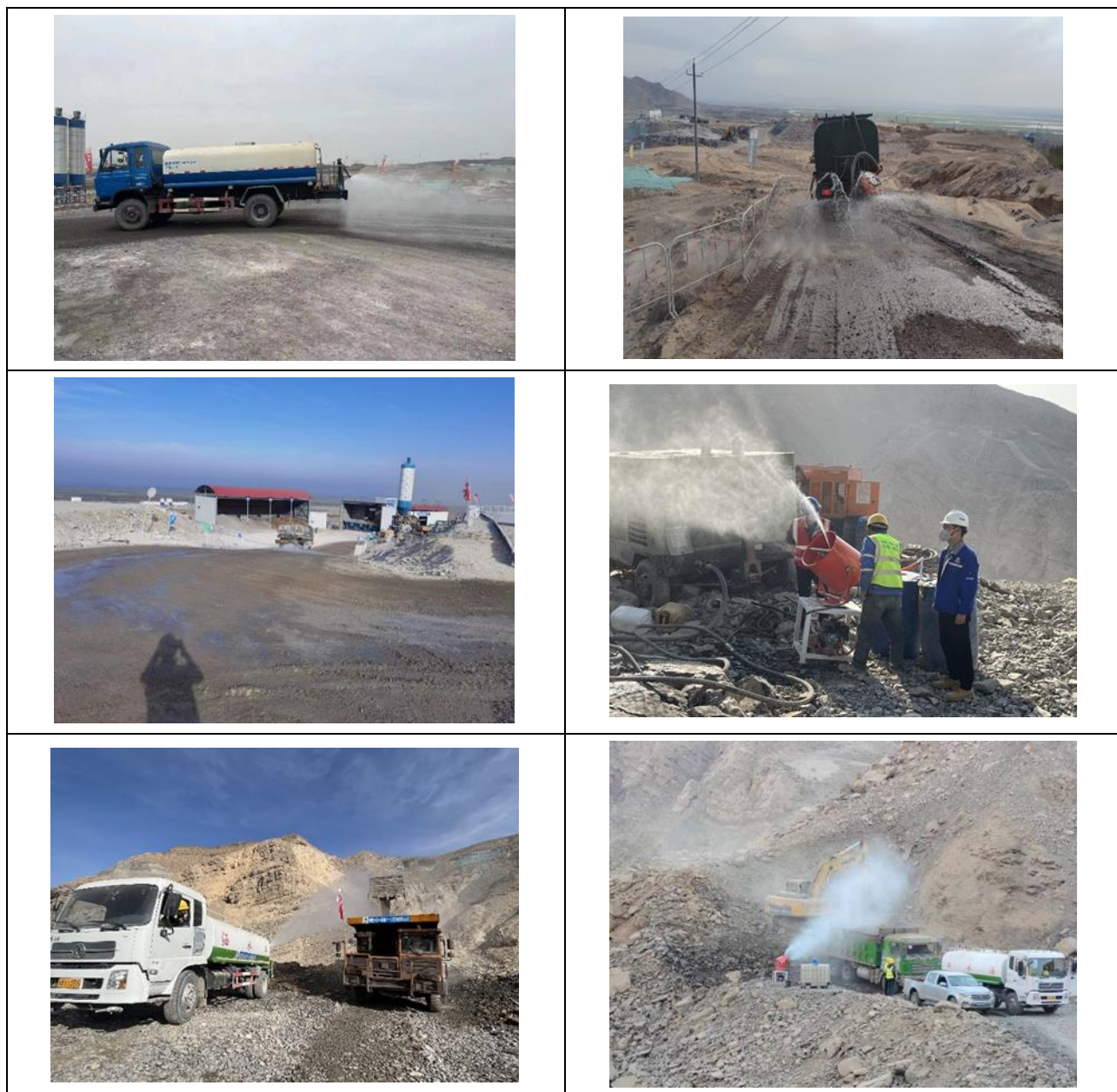
图 4.3-2 洒水降尘措施
