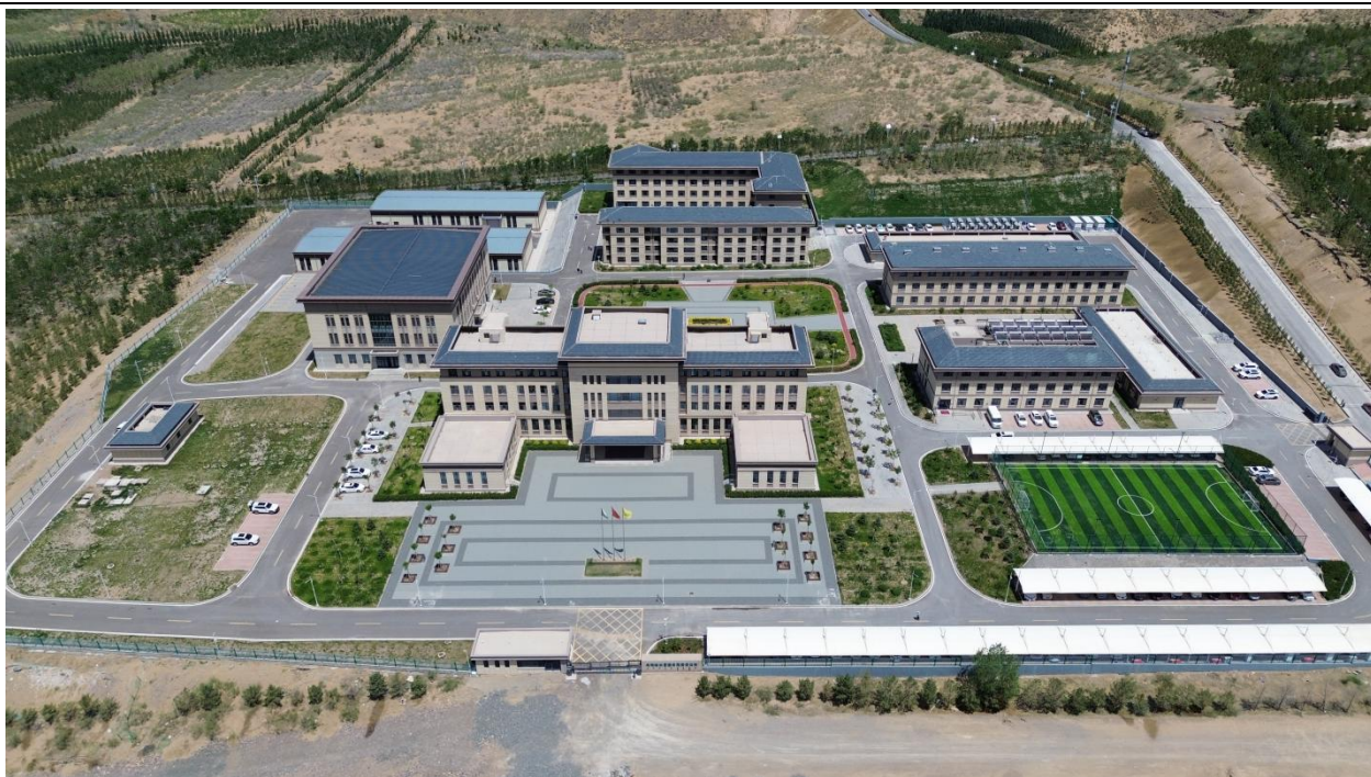
业主营地（永临结合）
