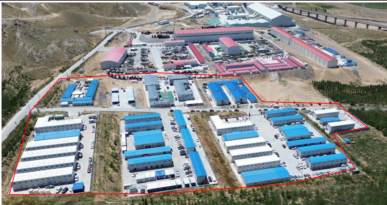
下水库施工营地
