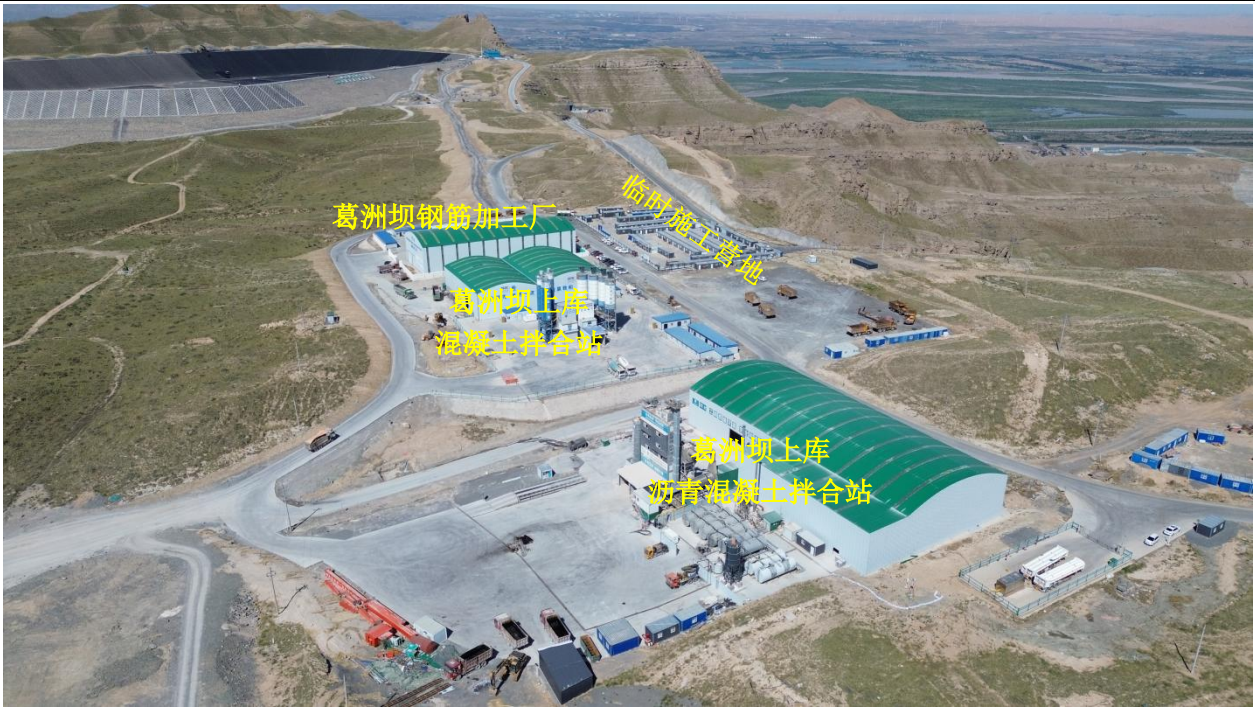
上水库临建设施
