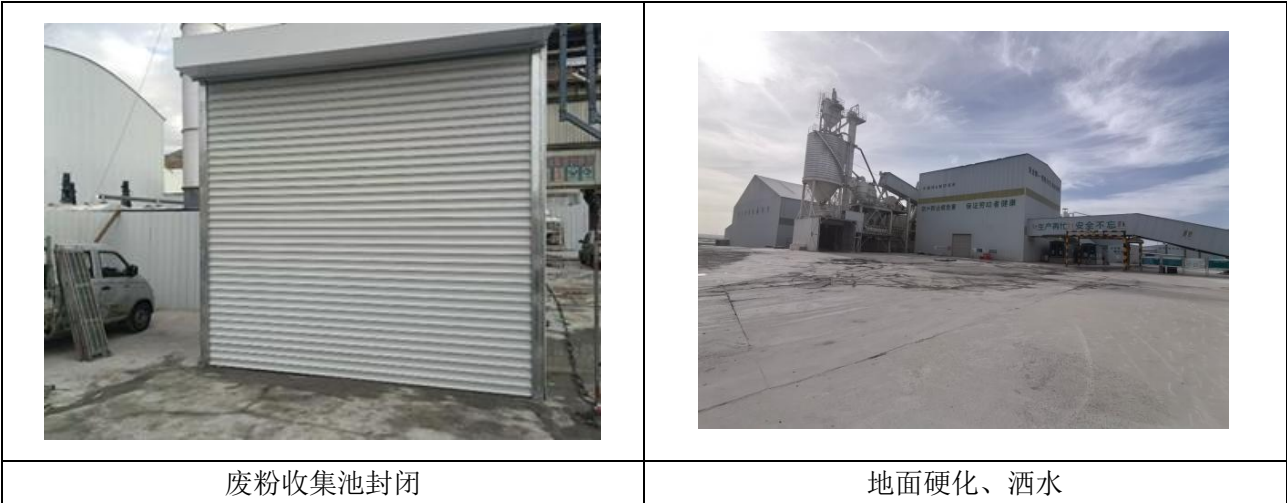
图 4.3-5 砂石料加工系统除尘措施
