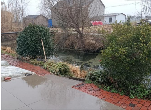
宋楼五队闸拆建前
