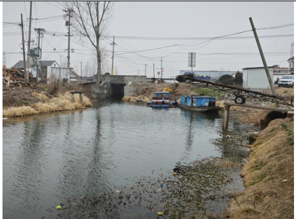
高丰闸站拆建前
