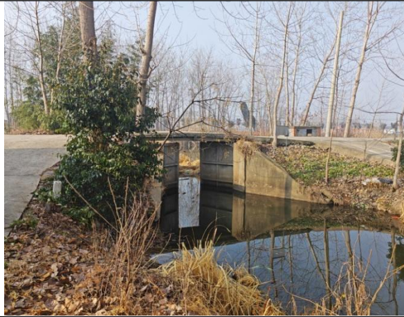
桥南七组北闸拆建前
