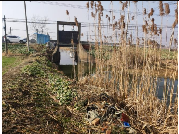
冈河闸站拆建前
