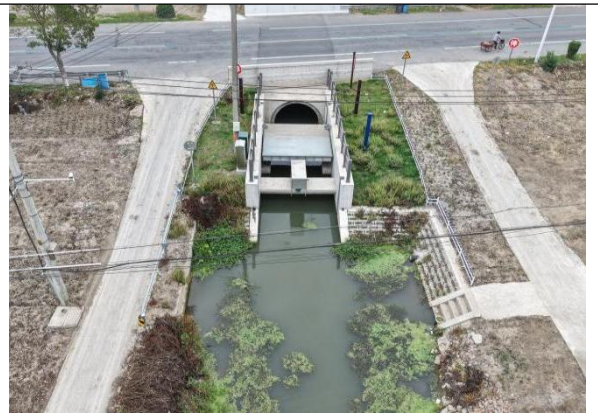
先锋闸拆建后
