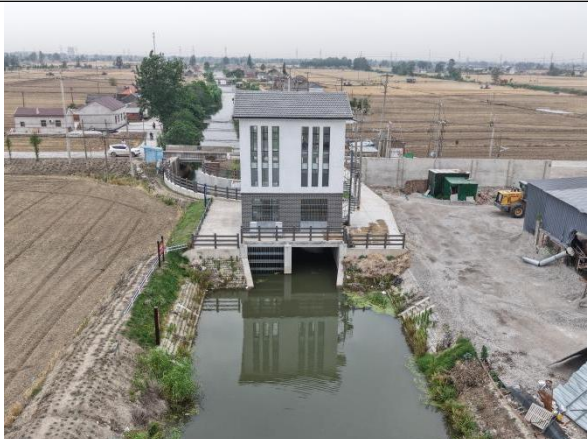
冈河闸站拆建后
