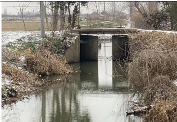
宋楼二队闸拆建前
