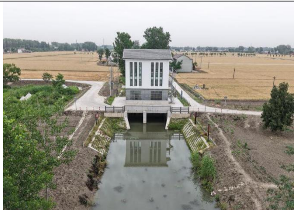
原新光八队闸站拆建后
