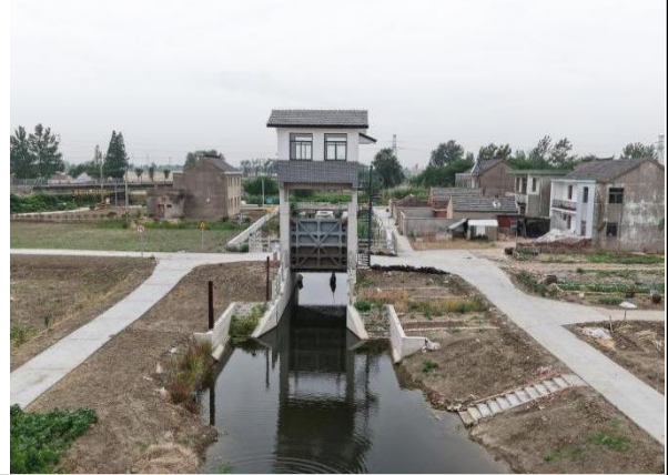
宋楼五队南闸拆建后
