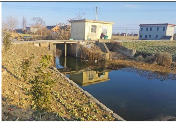
桥南七组南闸站拆建前
