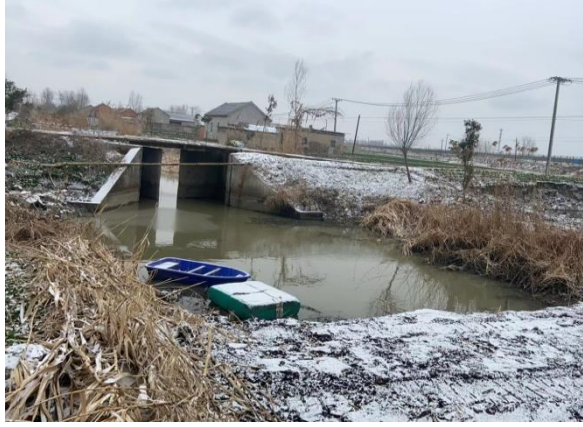
宋楼五队南闸拆建前
