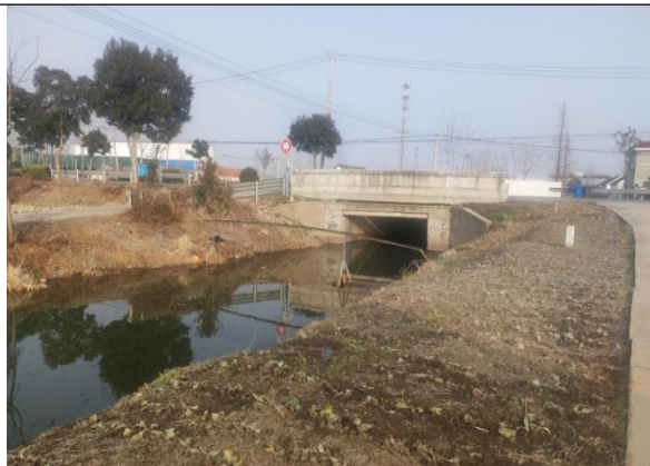
先锋闸拆建前
