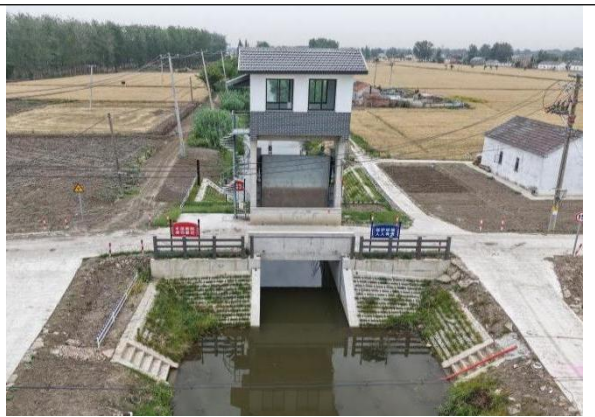
原新光七队北闸拆建后
