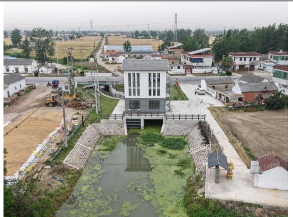
高丰闸站拆建后
