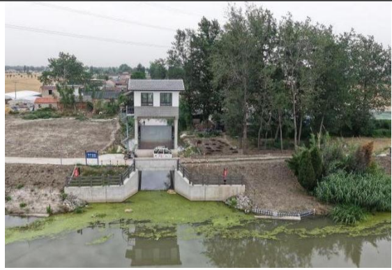
原新光八队南闸拆建后
