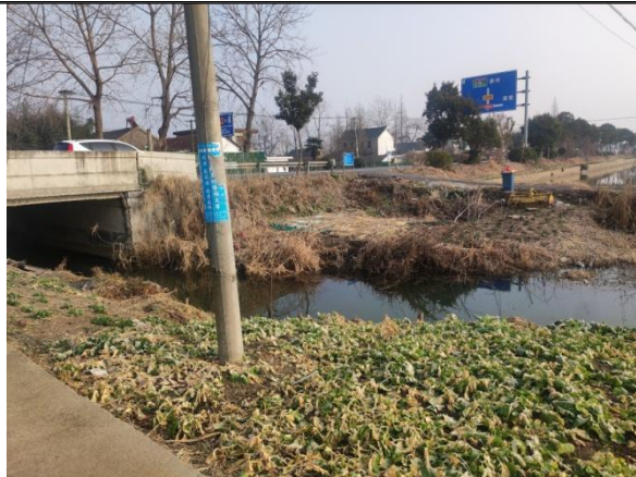
立新闻站拆建前
