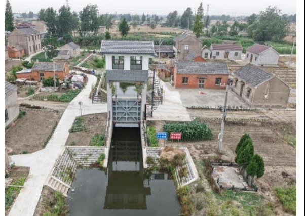
宋楼五队闸拆建后
