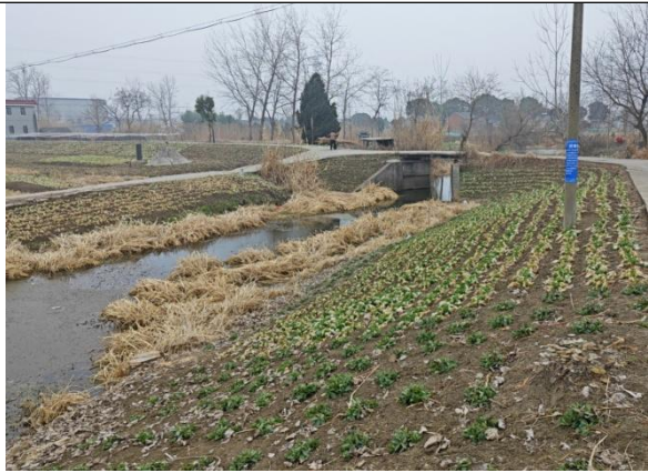
原新光八队闸站拆建前
