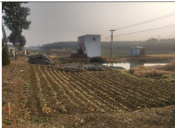
友谊闸拆建前
