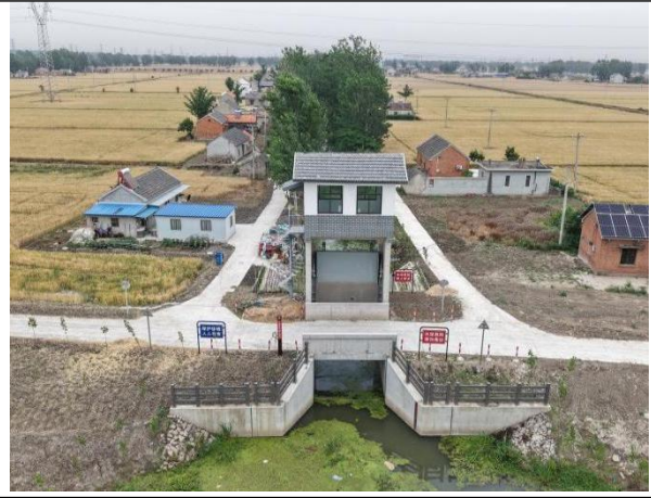
桥南七组北闸拆建后
