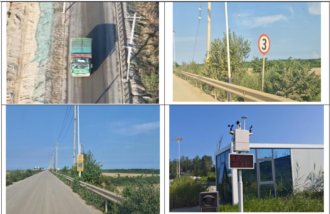
图 7-3 施工现场大气污染防治措施
