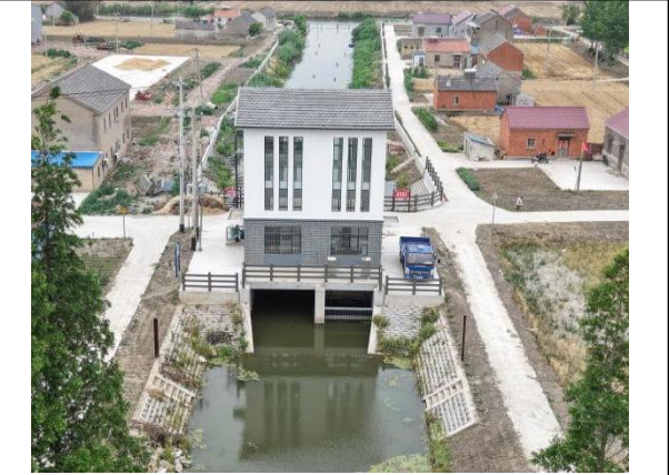
新北二队北闸站拆建后
