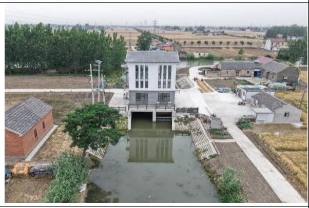
桥南七组南闸站拆建后
