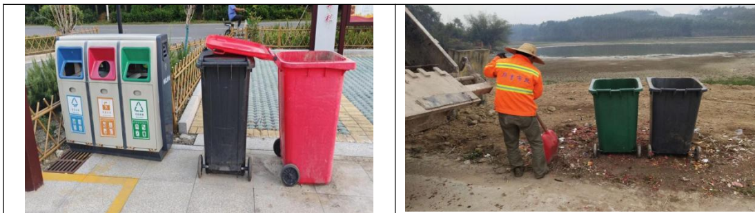
图 7-5 施工现场固体废物处置措施
