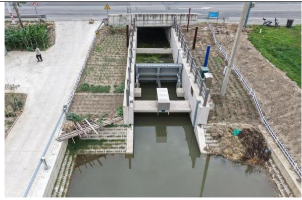
王庄闸拆建后
