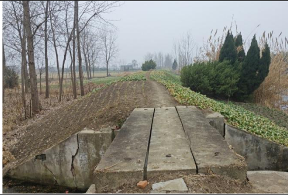
原新光八队南闸拆建前
