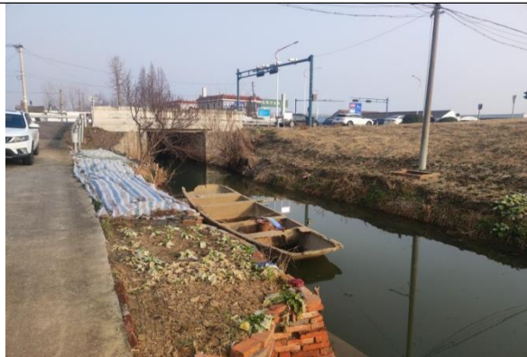
王庄闸拆建前
