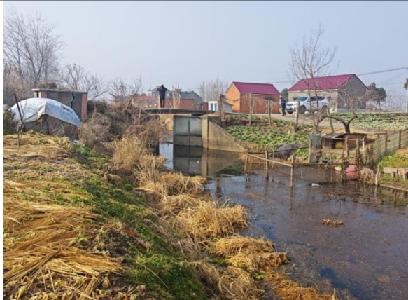
新北二队北闸站拆建前
