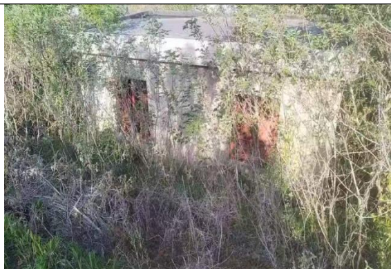
官塘六组站拆建前
