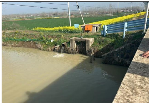
中东干渠节制闸拆建前
