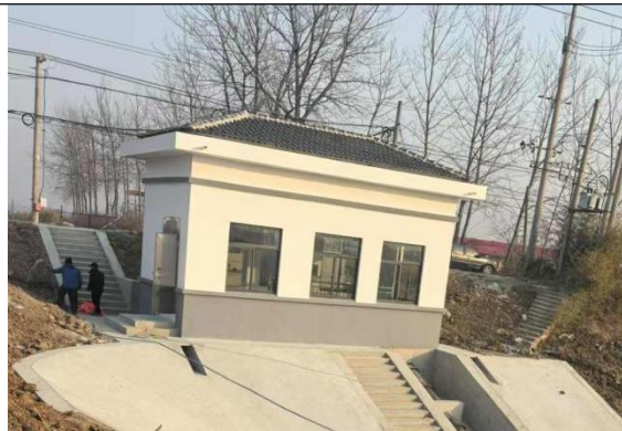
新塘大坝站拆建后
