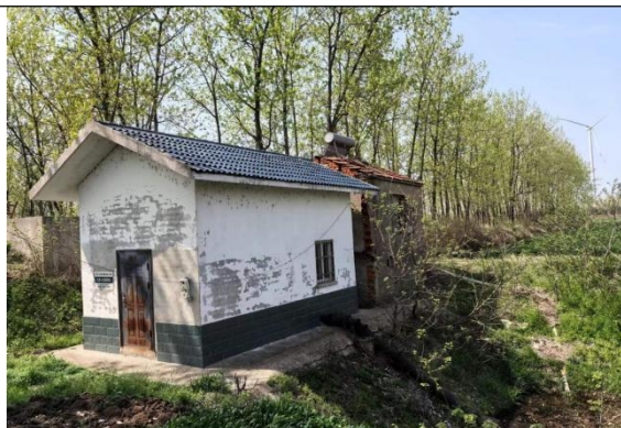
红岗七组站拆建前
