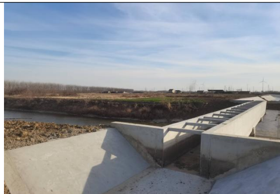
西干渠渡槽施工后
