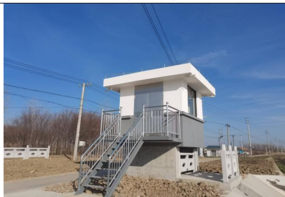
西干渠退水闸拆建后
