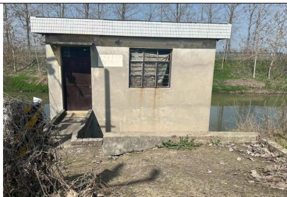
戴楼八组站拆建前
