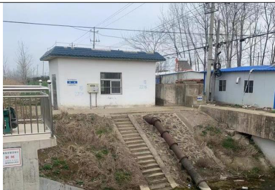
新塘二级站拆建前
