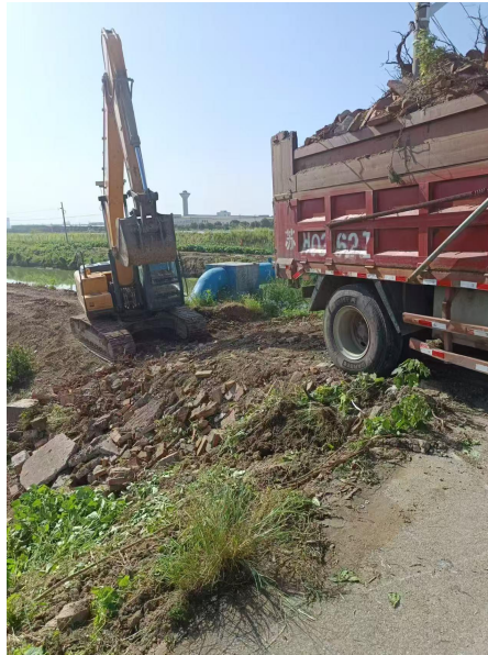
图 7-6 施工现场固废处理措施
