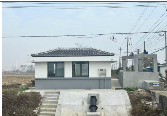
新塘二级站拆建后
