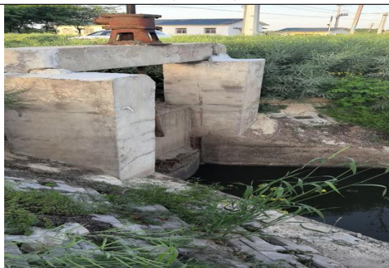
西干渠退水闸拆建前
