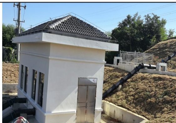
官东三级站拆建后
