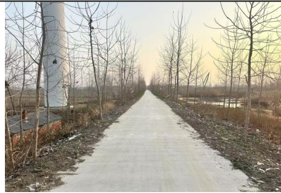
新塘西排涝站管理道路施工后
