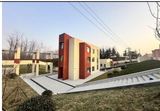
永丰泵站维修后
