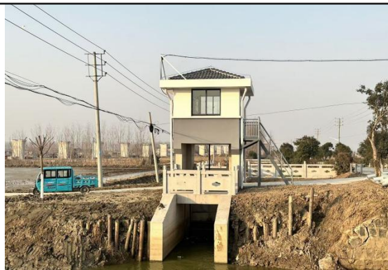
中东干渠节制闸拆建后
