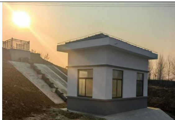
官塘六组站拆建后
