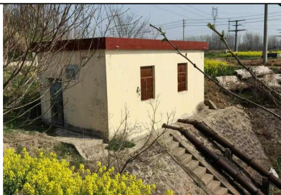
官东三级站拆建前
