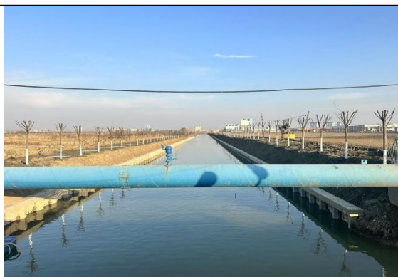
中东干渠施工后
