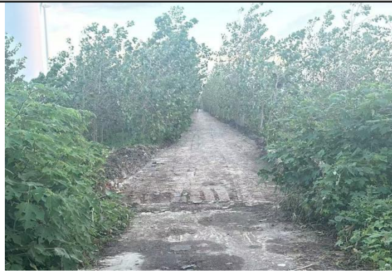
新塘西排涝站管理道路施工前
