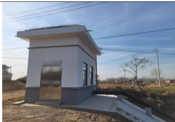
红岗四组站拆建后
