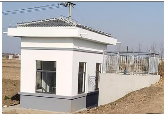
红岗七组站拆建后
