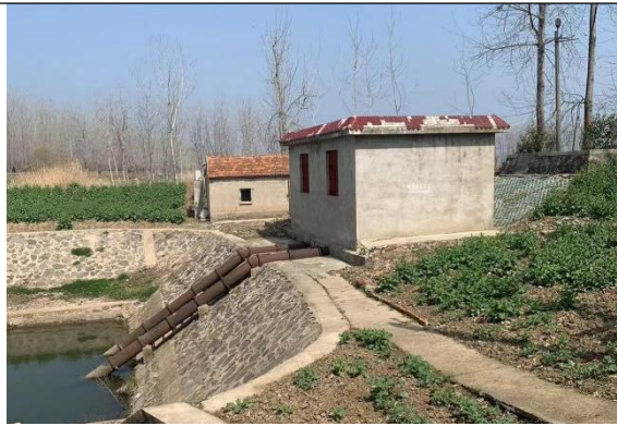
新塘东排涝站拆建前
