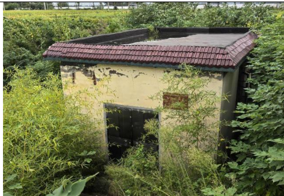
新塘大坝站拆建前
