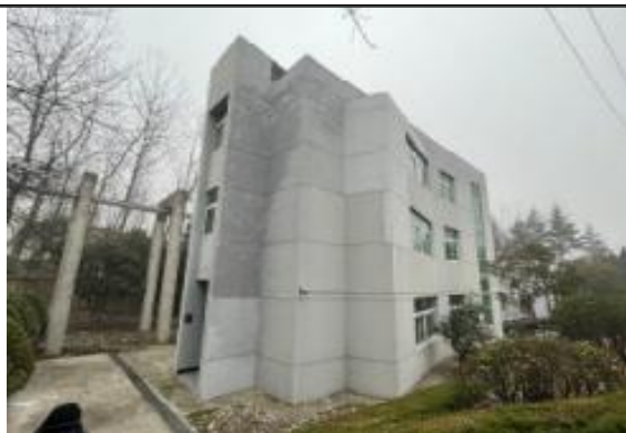
永丰泵站维修前
