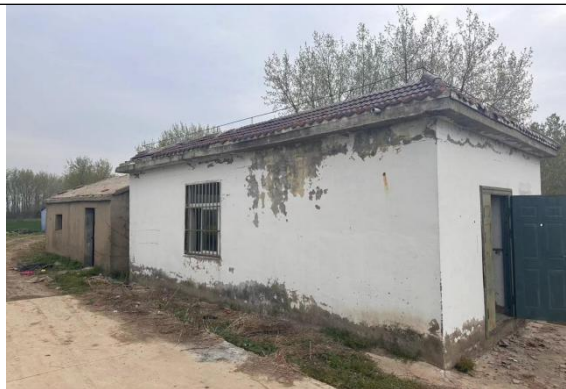
新塘一级站拆建前
