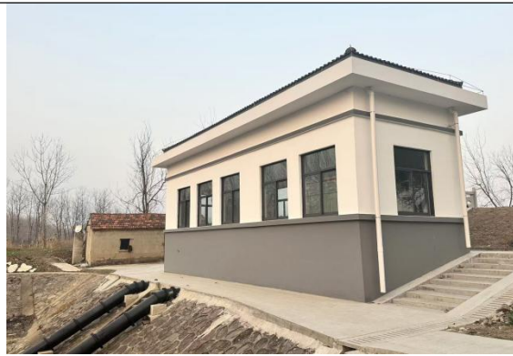
新塘东排涝站拆建后
