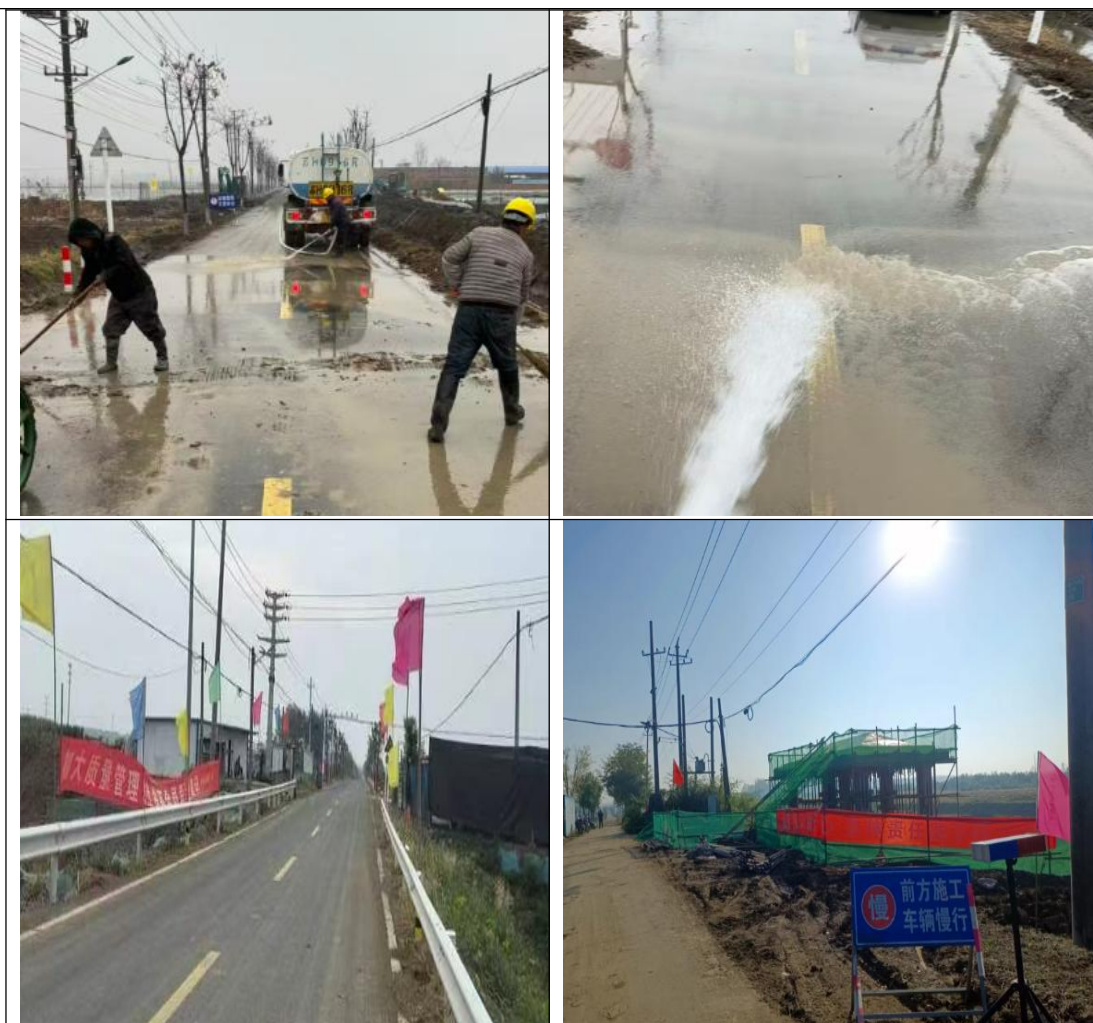
图 7-4 施工现场大气污染防治措施
