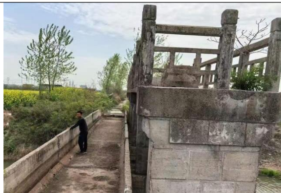
西干渠渡槽施工前
